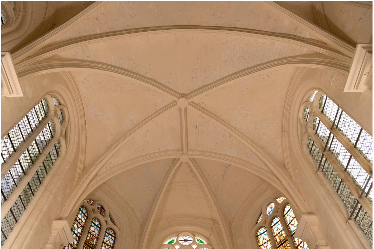
Voûtes du chœur.
