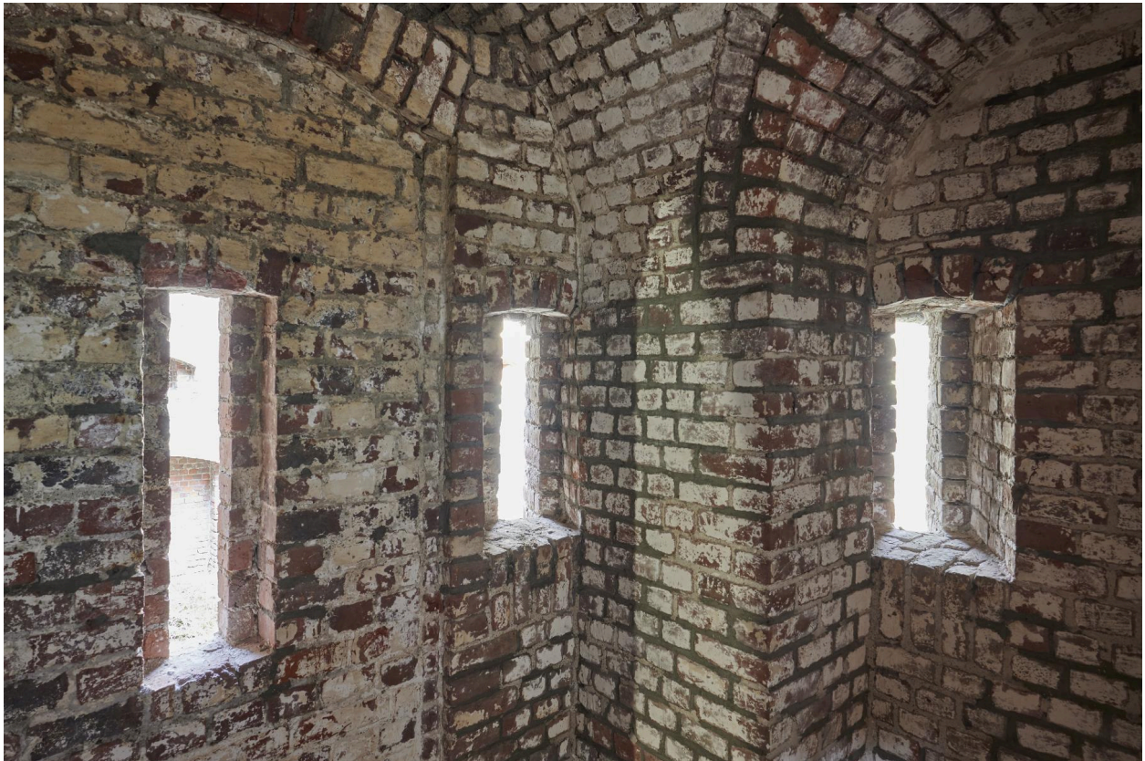
Créneaux de fusillade de la caponnière double.
