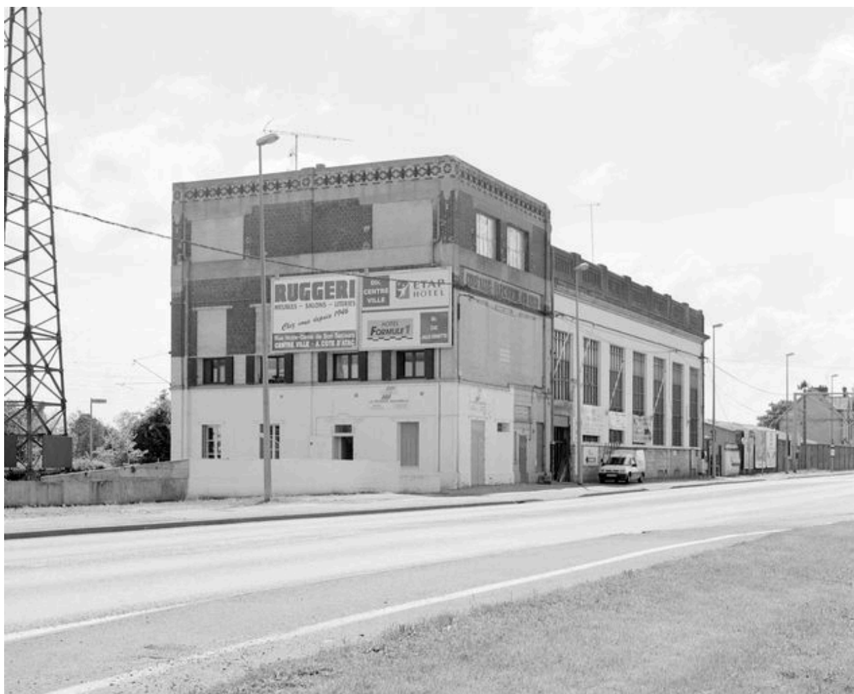
CLAIROIX. Compagnie Electrique du Nord. Vue générale.
