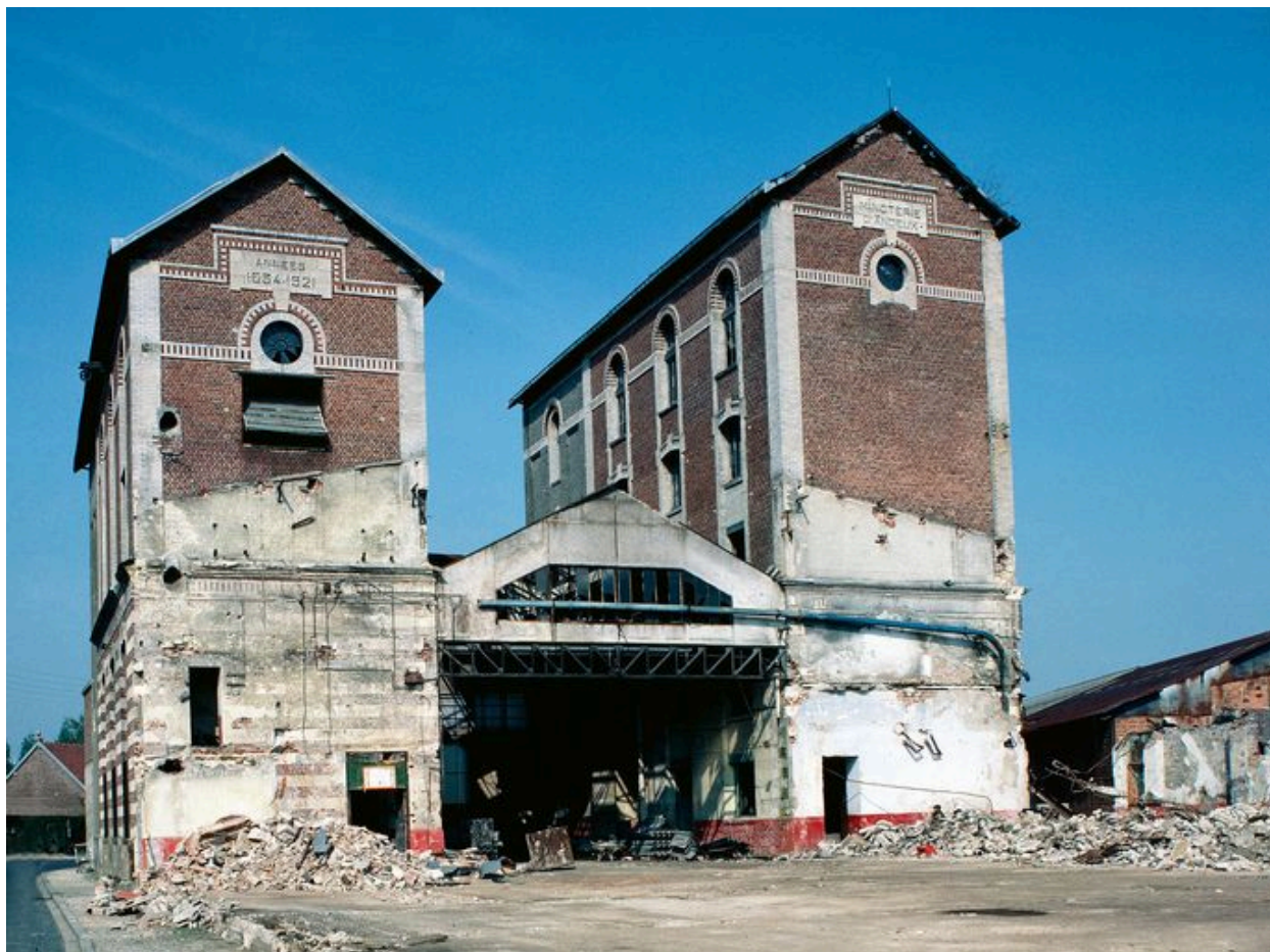
Vue en cours de destruction.
