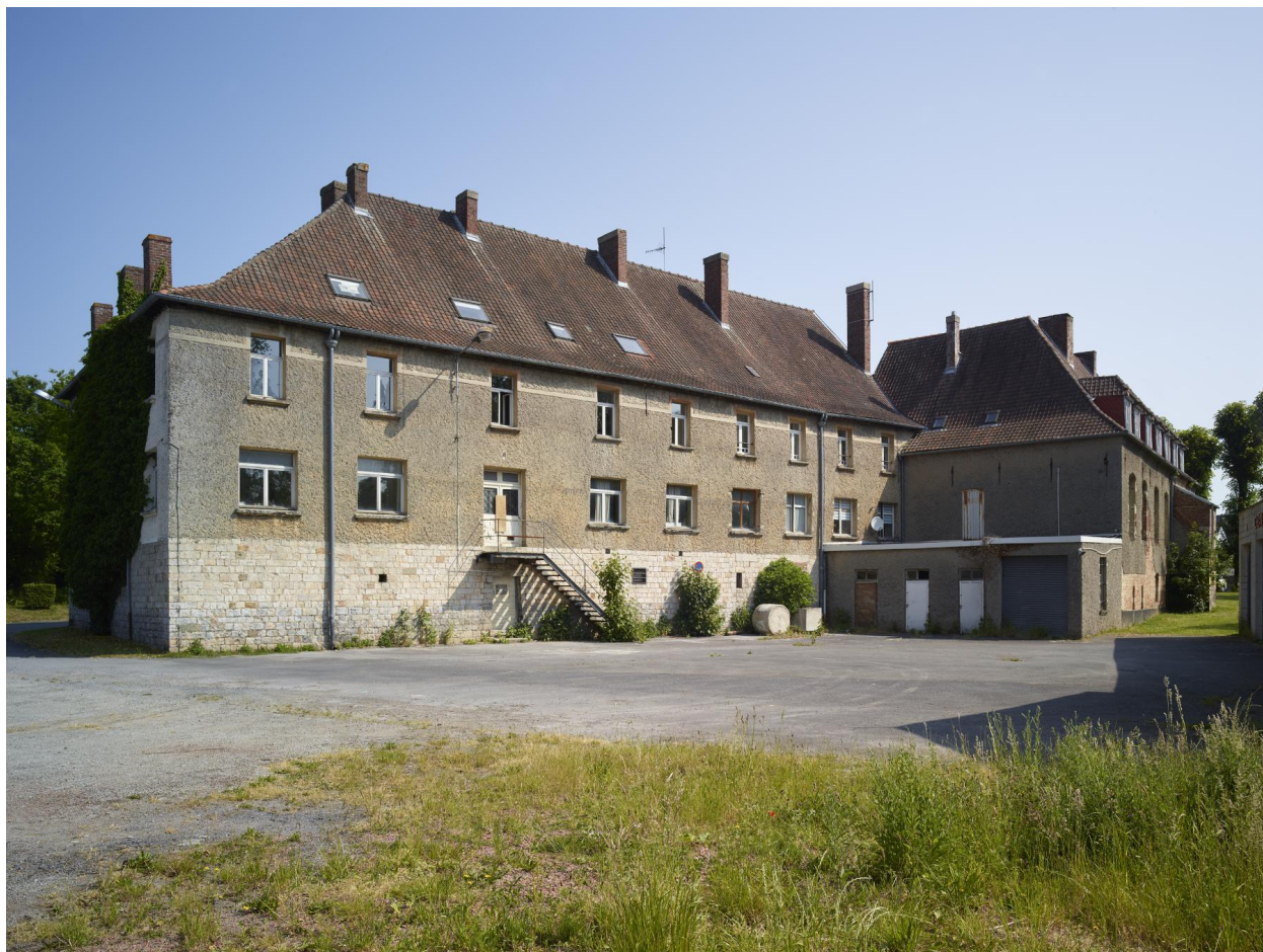
Caserne Cernay : façade arrière, détail de l'aile est. Vue orientée ouest - est.
