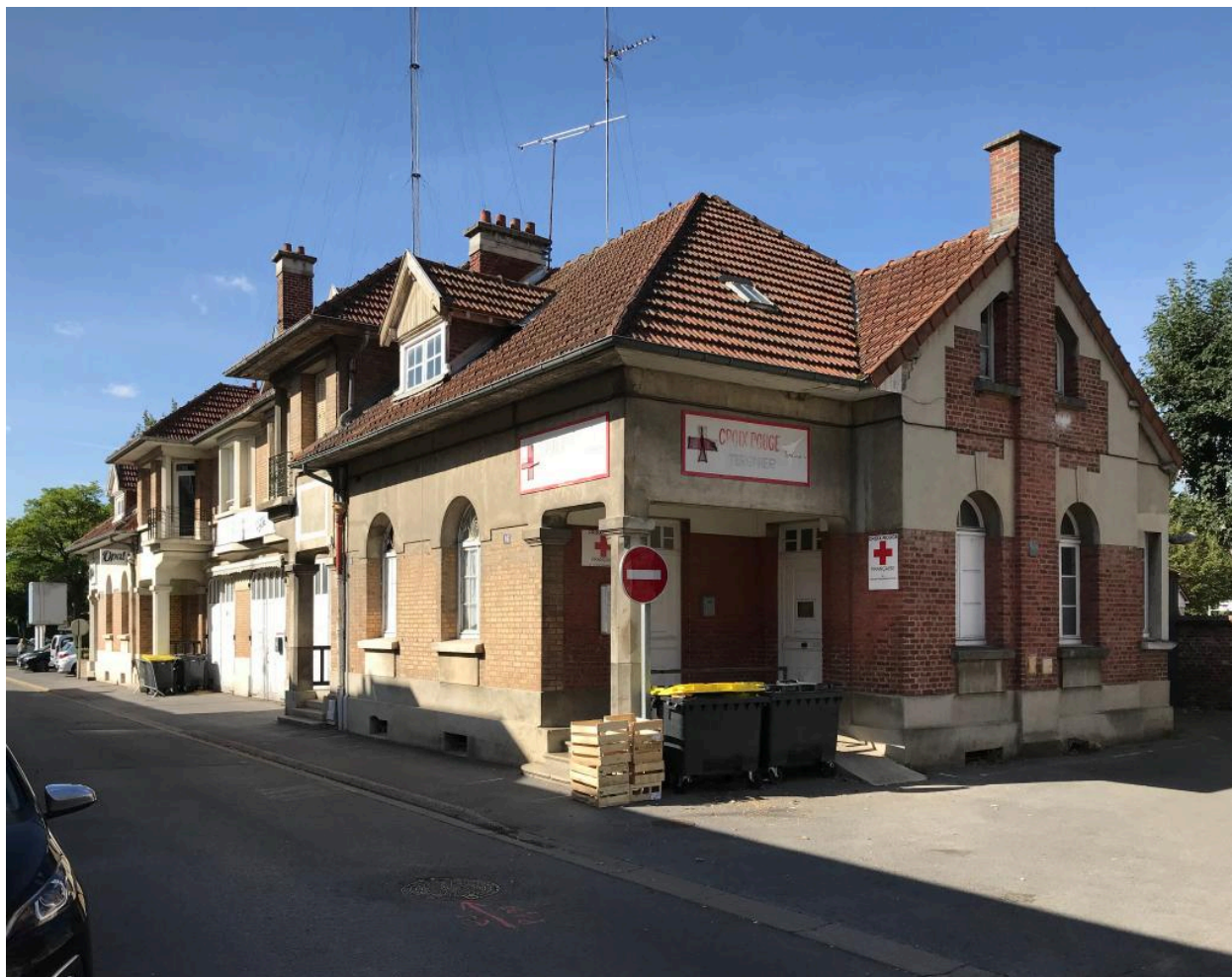
Vue générale, depuis le sud-est.
