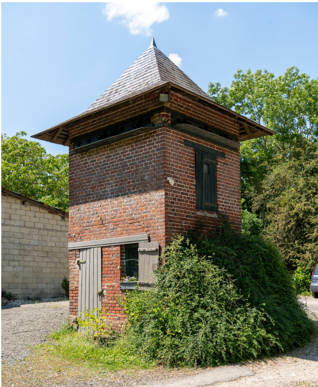
Pigeonnier, vue prise depuis le sud.
