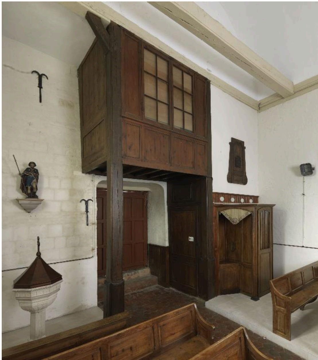
Escalier permettant l'accès au clocher.
