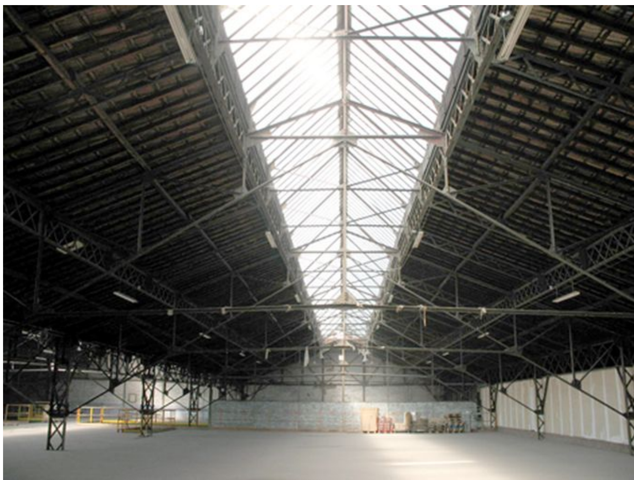
Charpente métallique des ateliers de montage.
