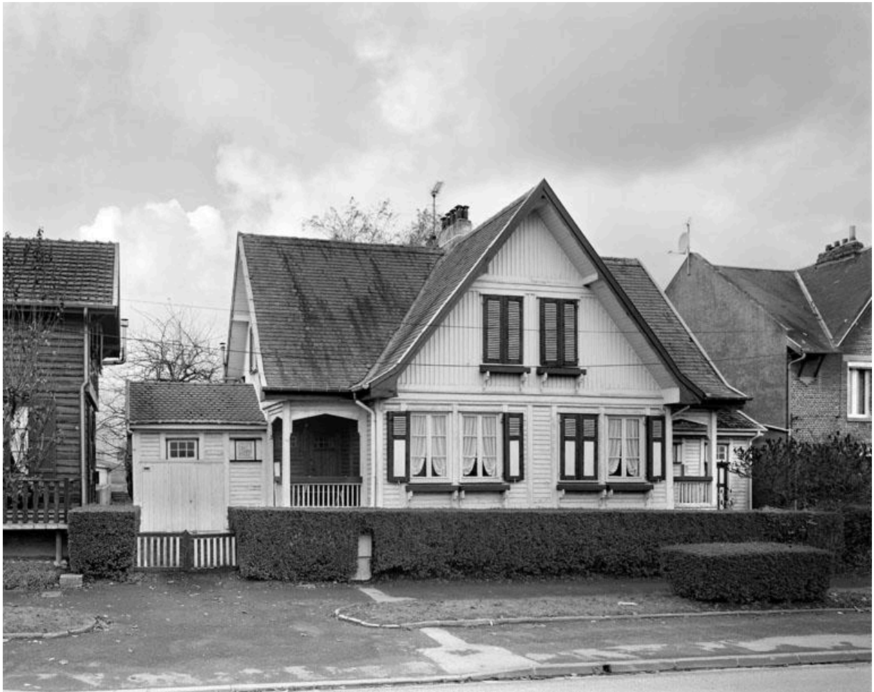
Vue de la façade sur rue.
