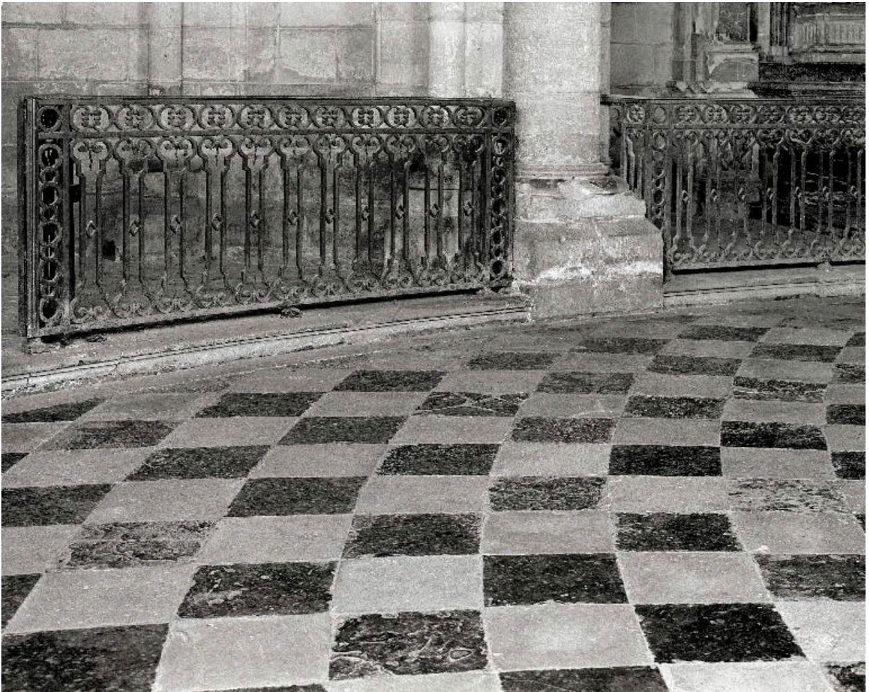
Détail du carrelage de sol du déambulatoire.
