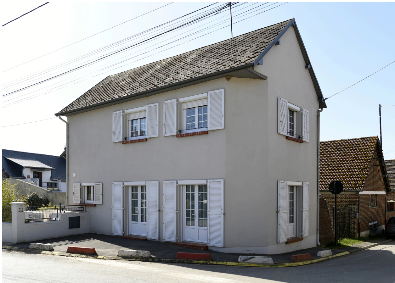
Ancien café, n°2 rue de Caply (sur le carrefour). Vue prise depuis le nord-ouest.
