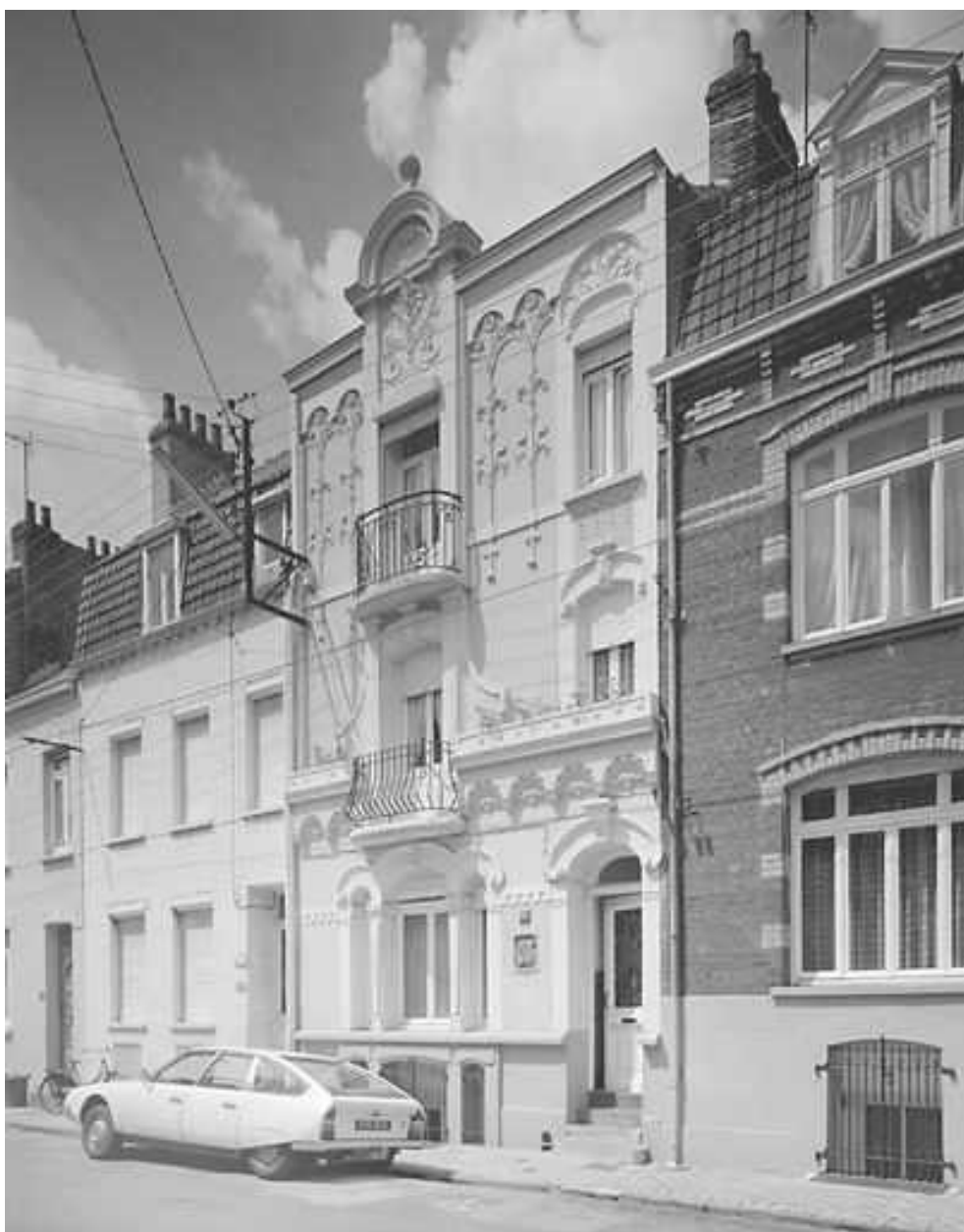
Vue d' ensemble de la façade.
