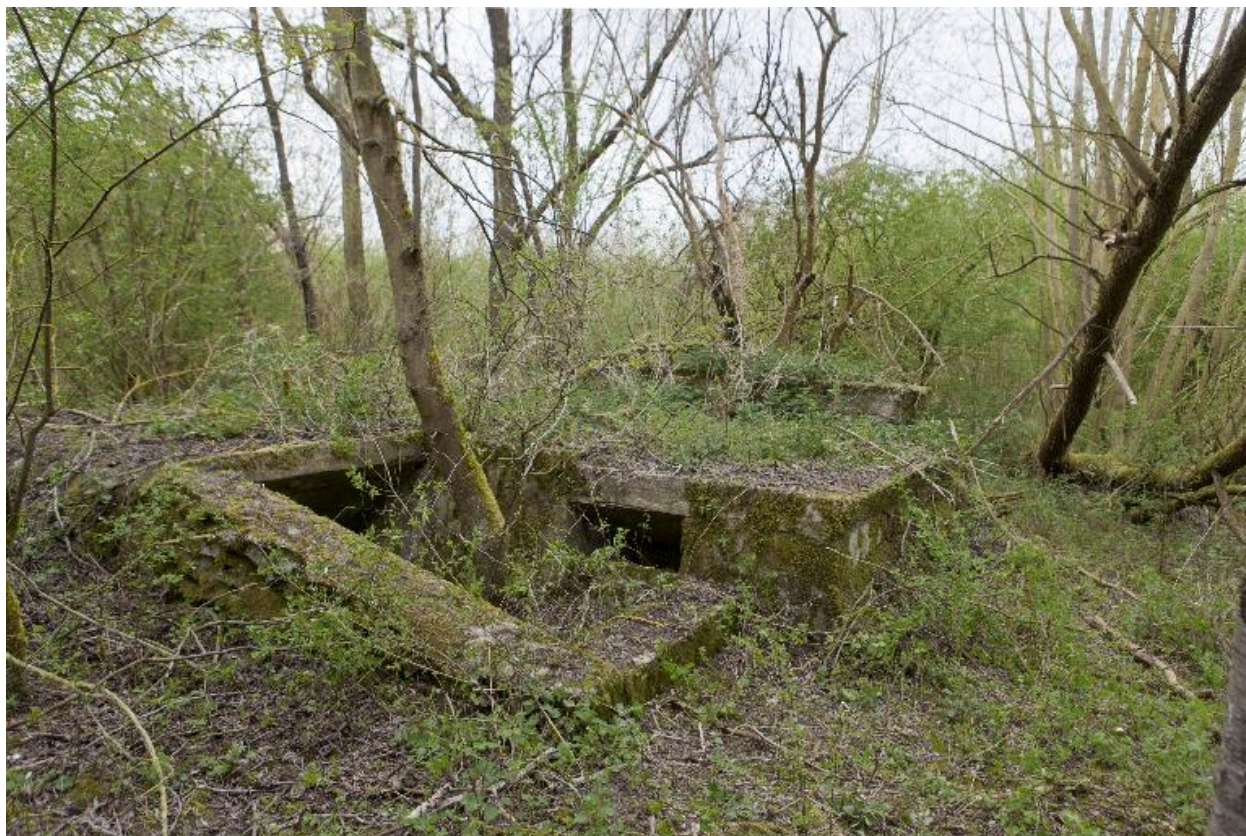
Edifice a. Vue générale, vers le nord
