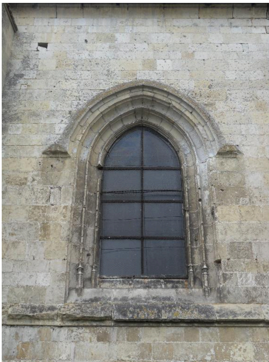
Baie du mur nord.
