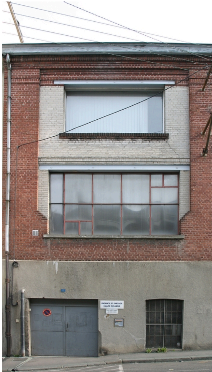
Travée d'atelier, rue Jean-de-Caulaincourt.
