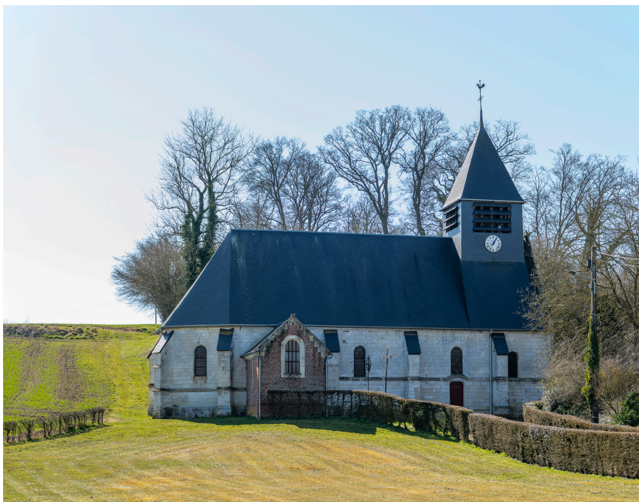
Vue générale de l'élévation nord.
