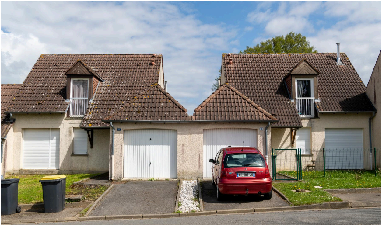
Lotissement HLM des Haies Villet, n°5-3 de la Grande Rue, vue prise depuis l'ouest.
