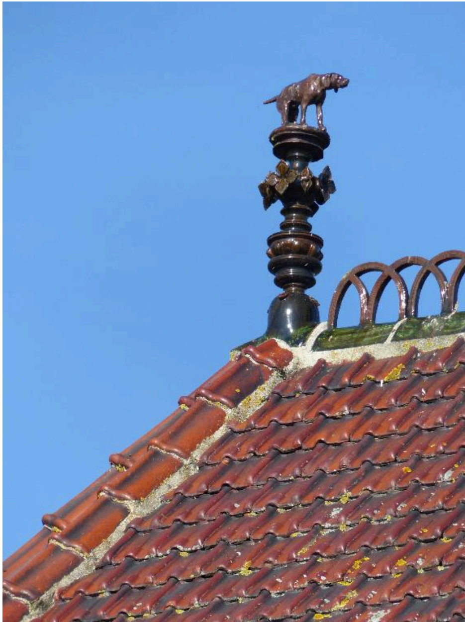
Vue de détail sur l'épi de faîtage.
