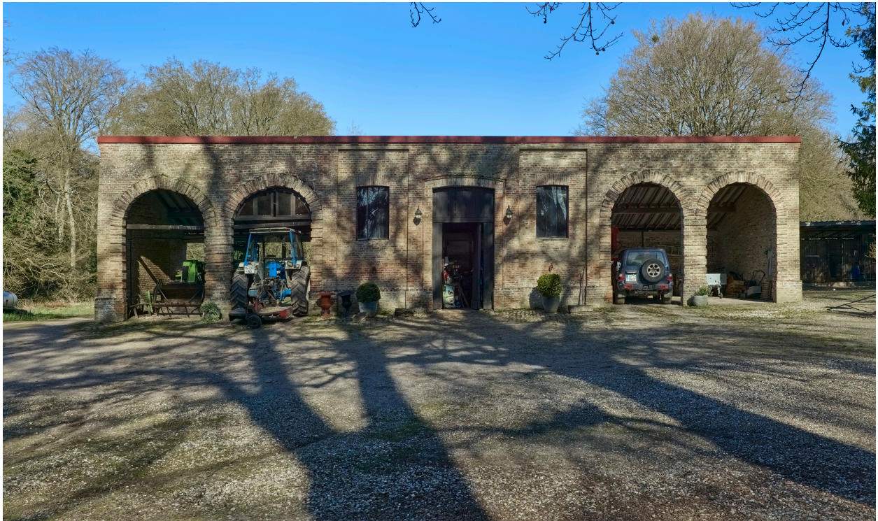
Vue de l'ancienne écurie dépendant du relais de chasse, depuis le sud-est.
