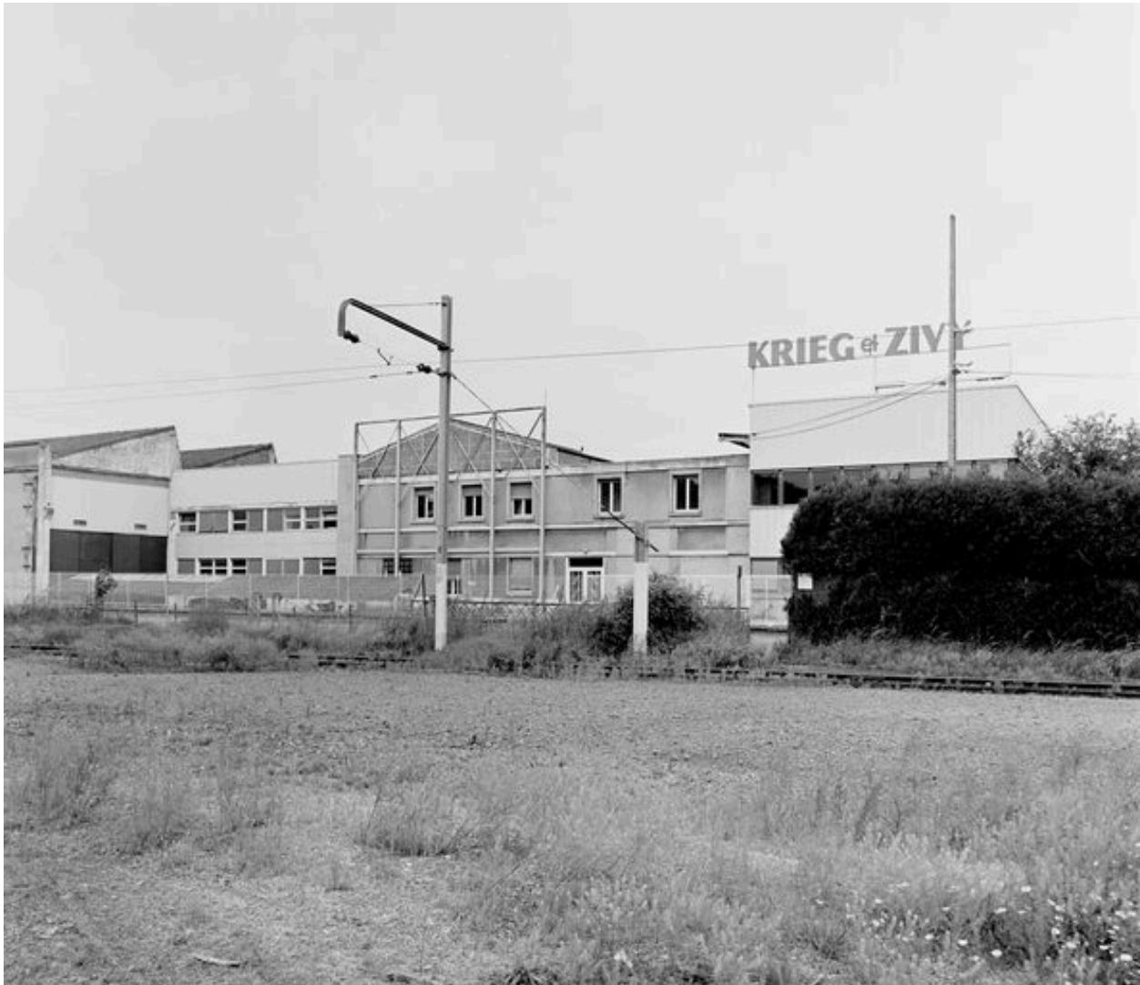
Vue générale, flanc sud.
