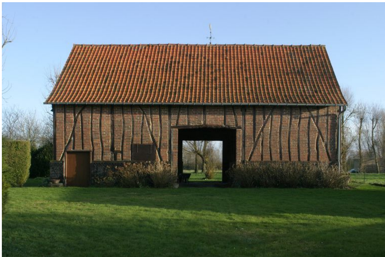
Vue de la grange.
