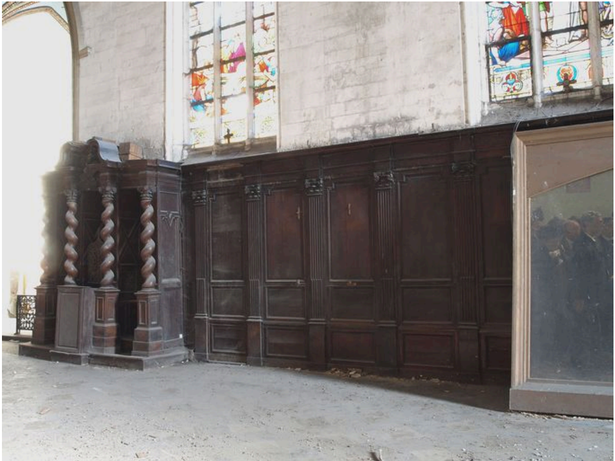
Vue générale, bas-côté sud
