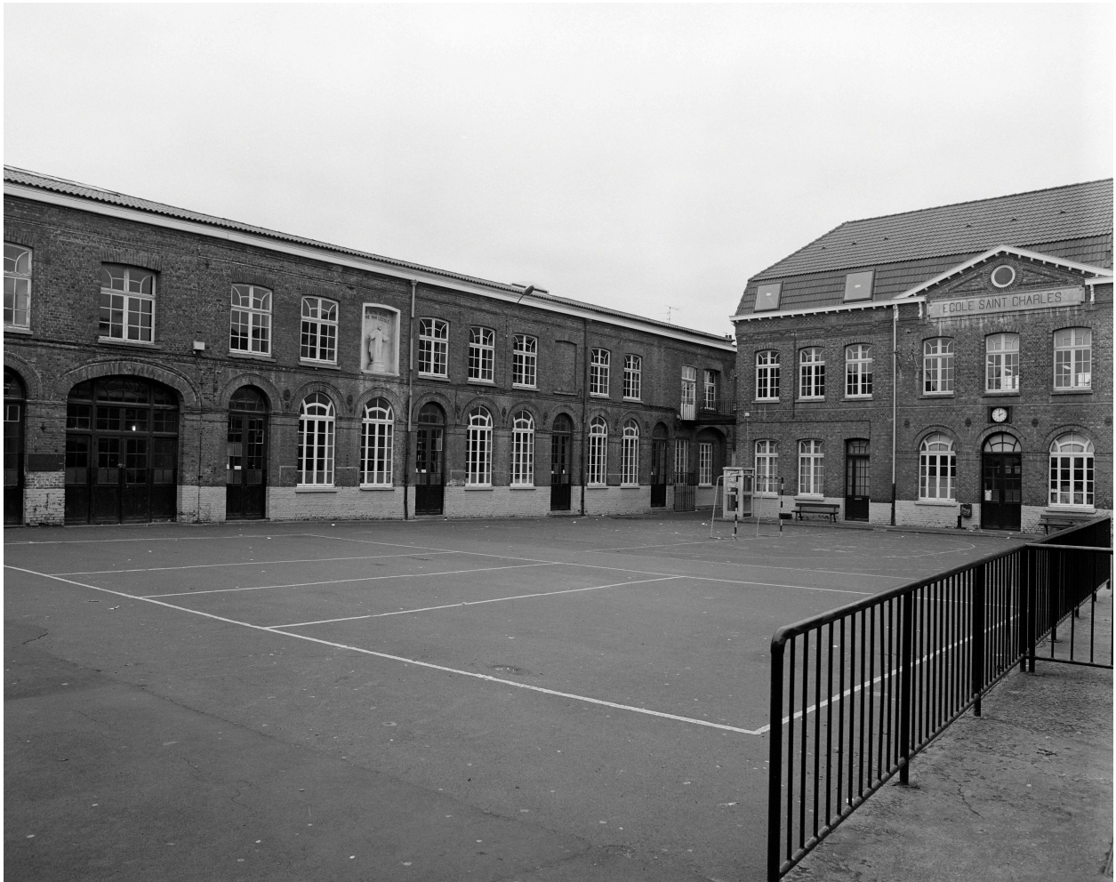
Atelier de fabrication. Vue prise vers l'ouest.
