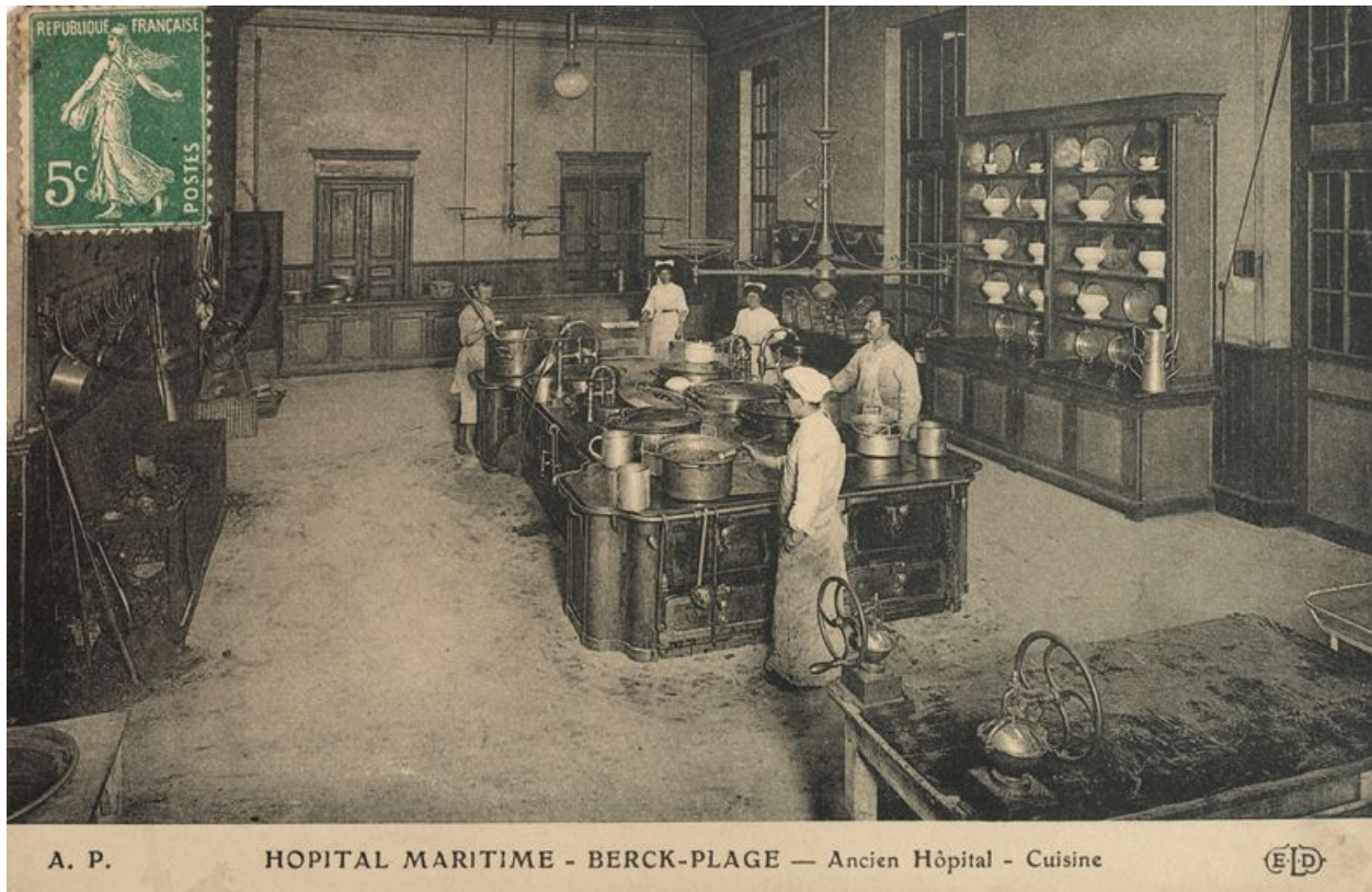
Cuisine, vue intérieure générale.
