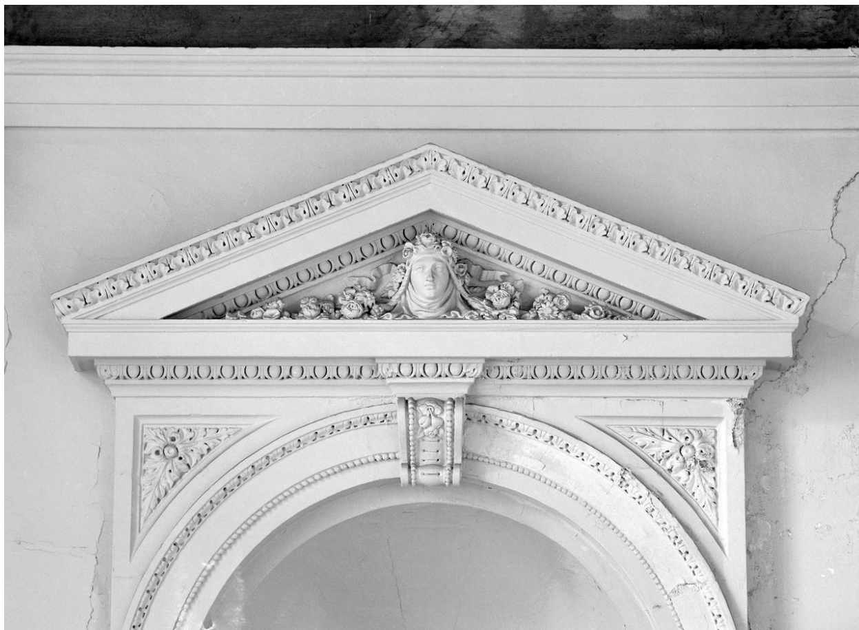
Fronton de la niche de l' escalier.
