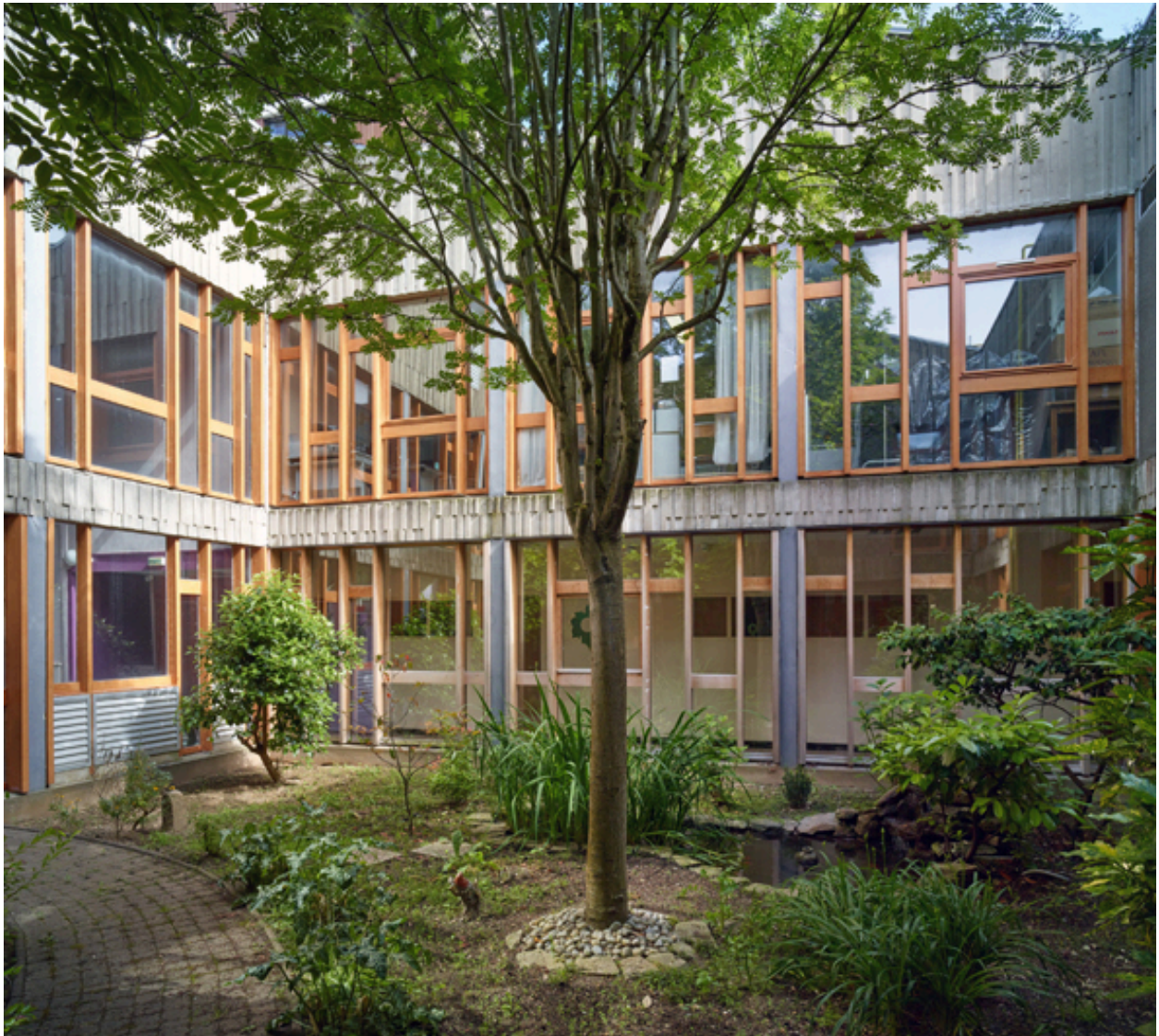
Vue générale du patio des anciennes cuisines du C.E.S., avec les menuiseries originales.
