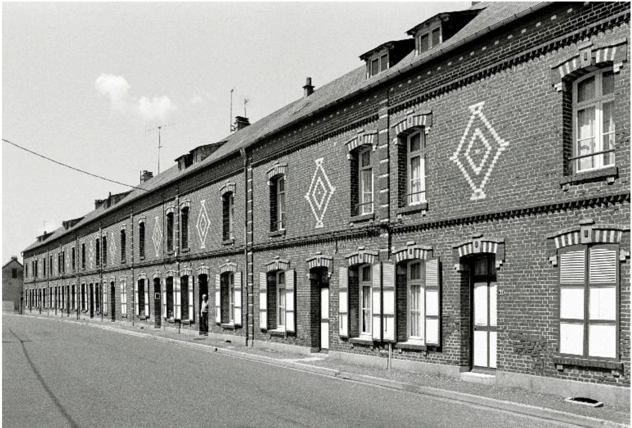
Vue générale de la cité ouvrière depuis la rue Emile-Zola, en 1990.
