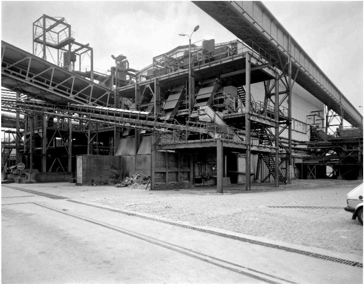
Unité de lavage.
