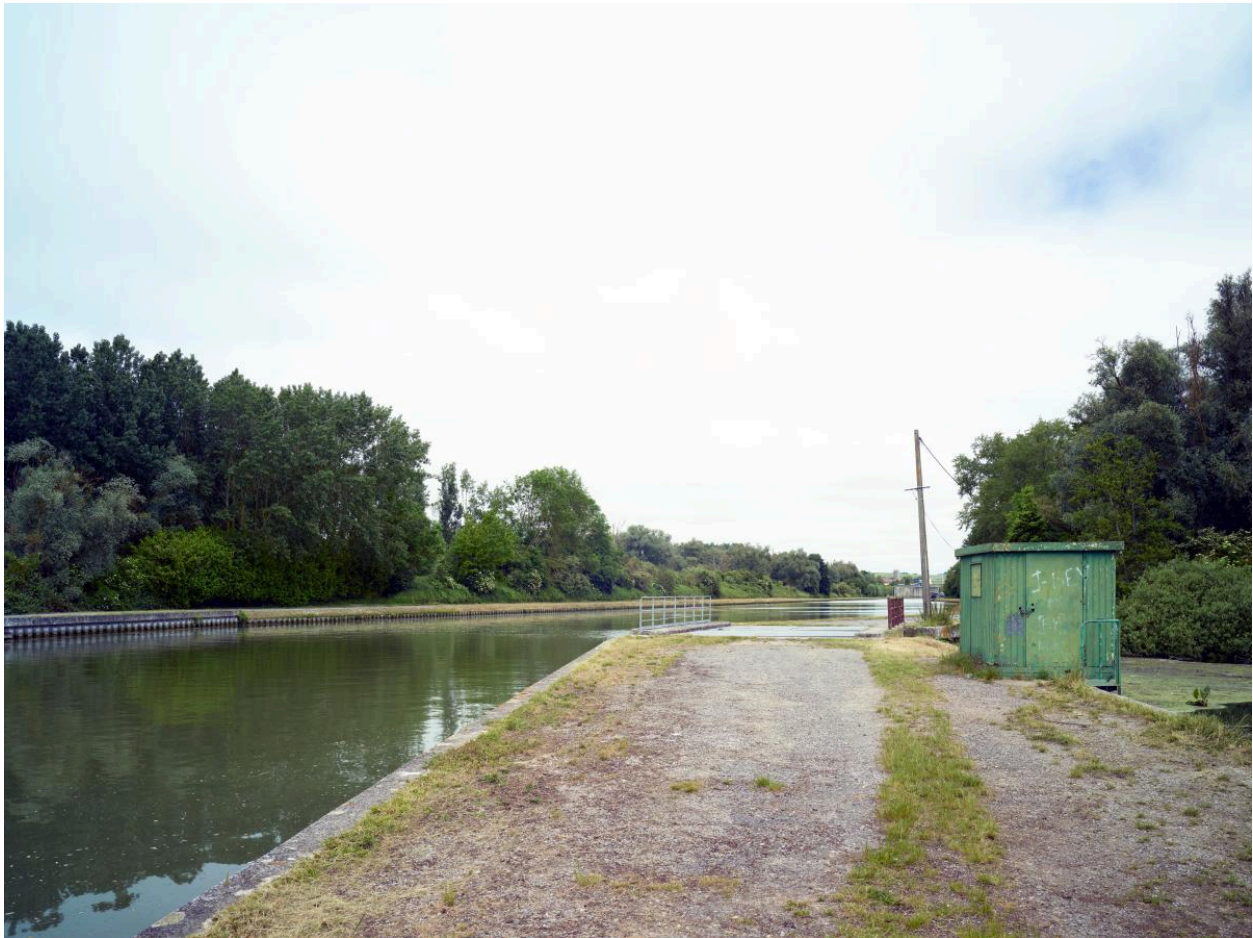
Vue depuis le sud-est. Voie de circulation. En vert, vanne de pilotage du siphon.
