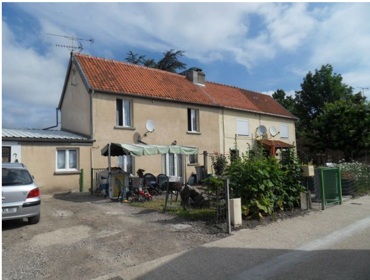
Maison à étage à deux unités d'habitation, rue Victor-Hugo (ancienne ruelle Blond).
