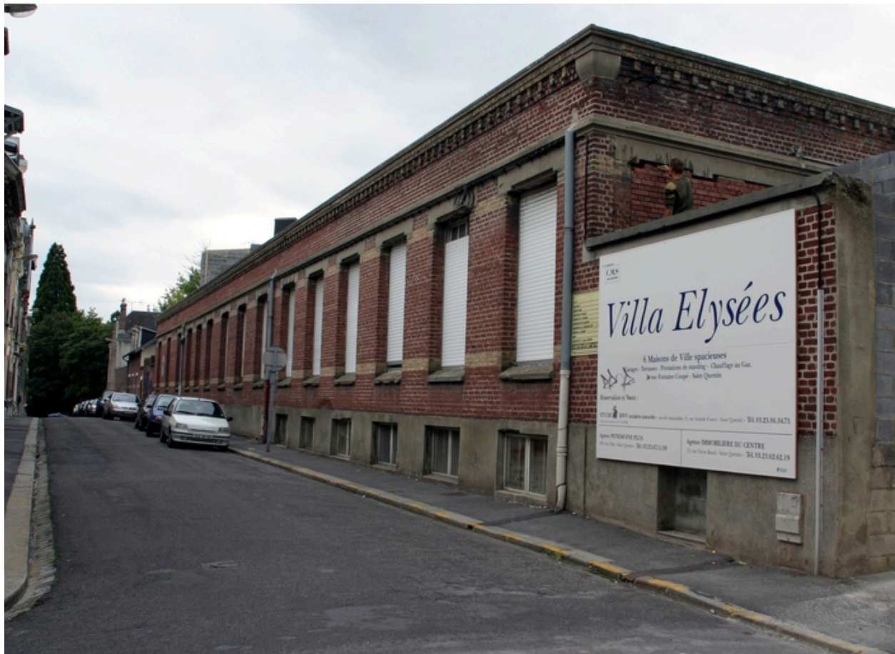
Façade des bureaux bordant la rue Fontaine-Coupé.
