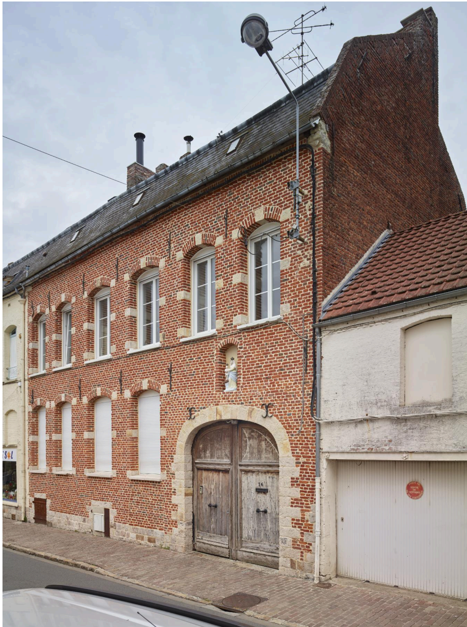
Ancienne école des Sœurs de Sainte-Thérèse d'Avesnes - 16-18, rue du Général-Bouttiaux : détail de la partie non modifiée de la façade, vue orientée est-ouest.
