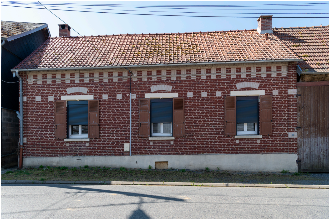
Logis sur rue de la Première Reconstruction, n°82 de la rue Casimir-Maumené, vue depuis le nord.
