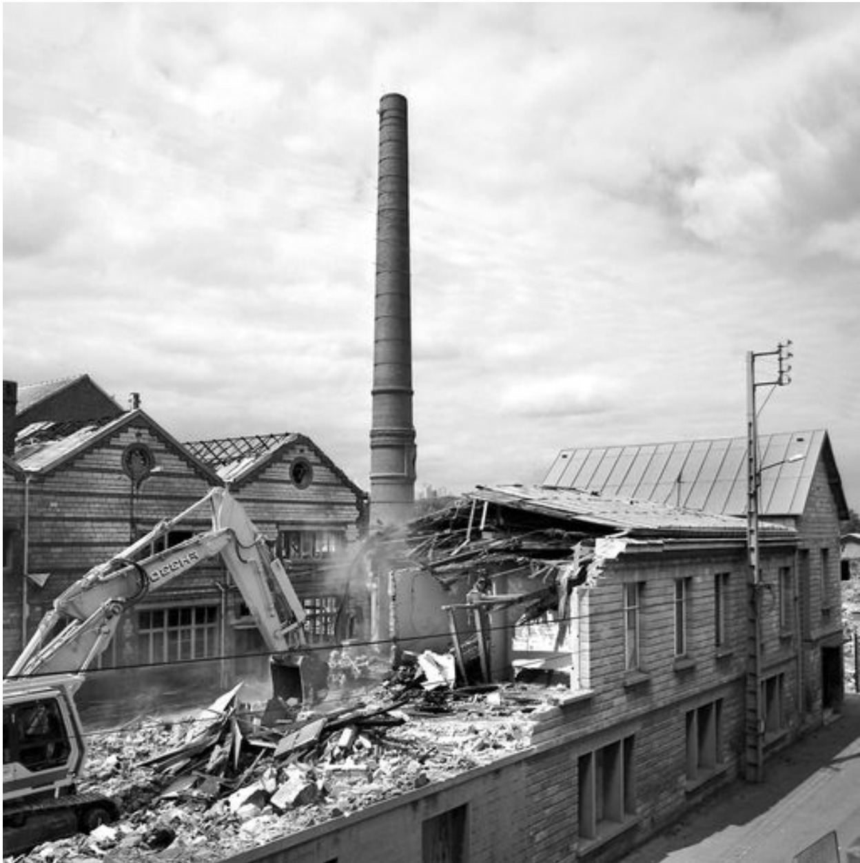
Démolition des bureaux, en 1999.
