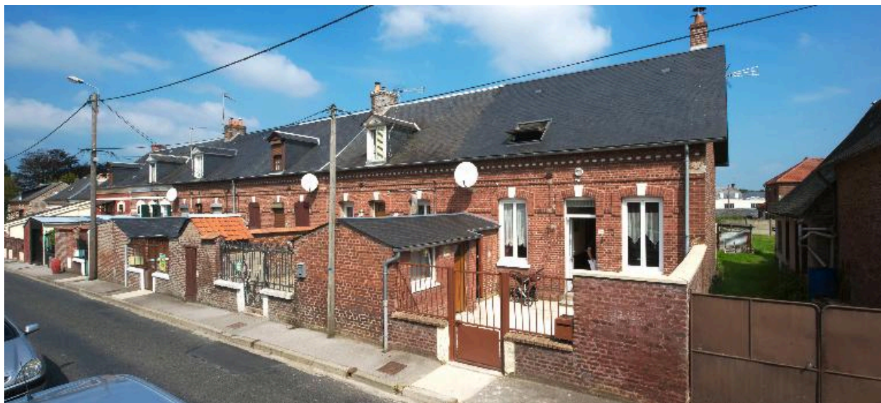
Vue générale depuis le sud.
