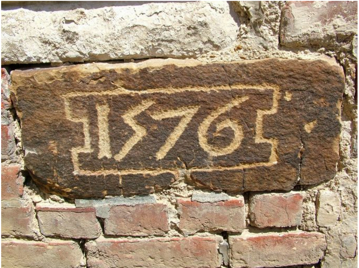
Bloc de grès inséré à la base sud du mur-pignon du choeur, et portant la date de 1576.
