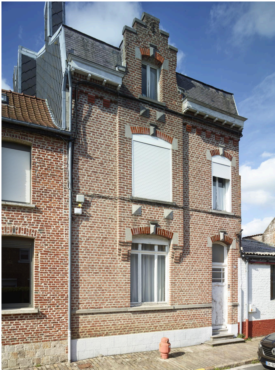
Maison - 32, rue Baillon : maison réhaussée présentant une façade Art déco.
