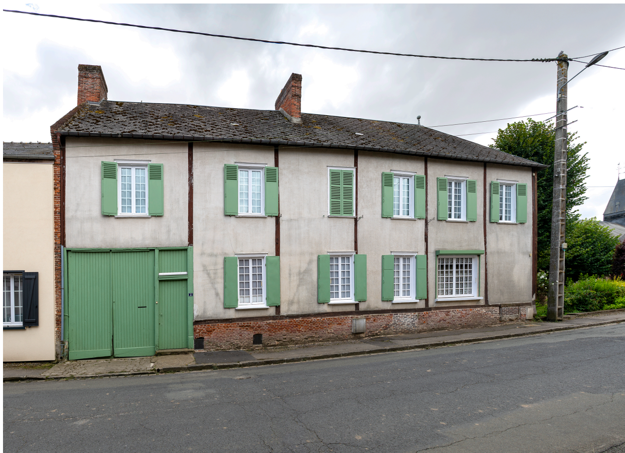
Logis sur rue, n°2 de la rue du Bail, vue depuis le nord.
