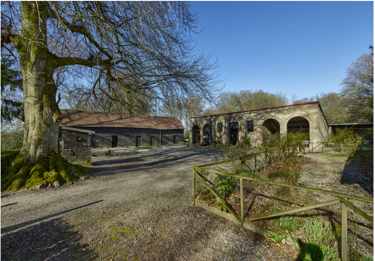
Vue de la cour des dépendances de l'ancien relais de chasse, depuis l'est.
