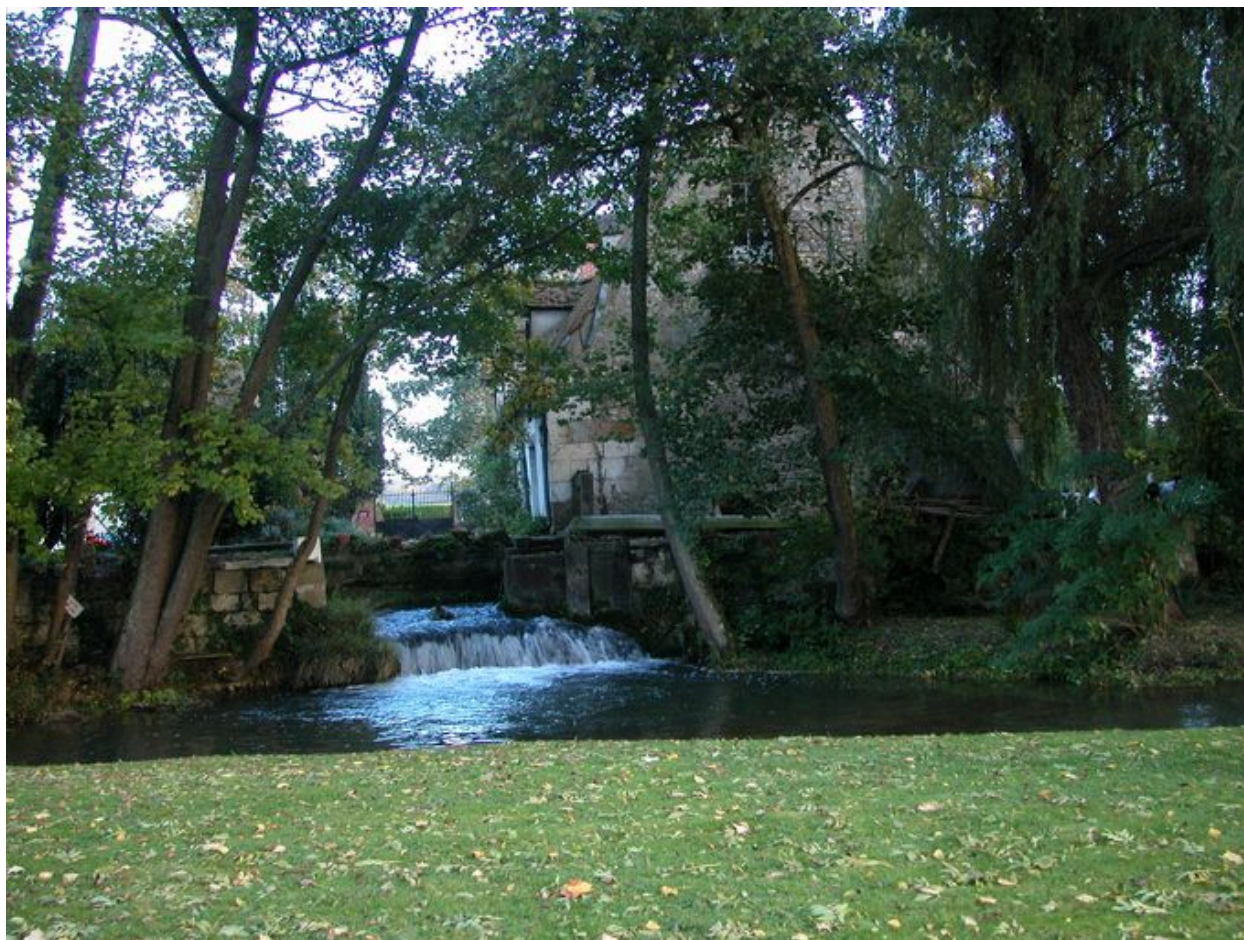
Vue du déversoir et du vannage de décharge.
