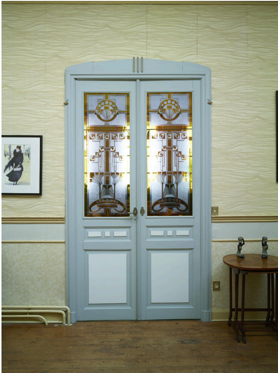
Porte à deux vantaux entre le salon et la salle à manger avec panneaux supérieurs en vitrail : vue depuis la salle à manger.
