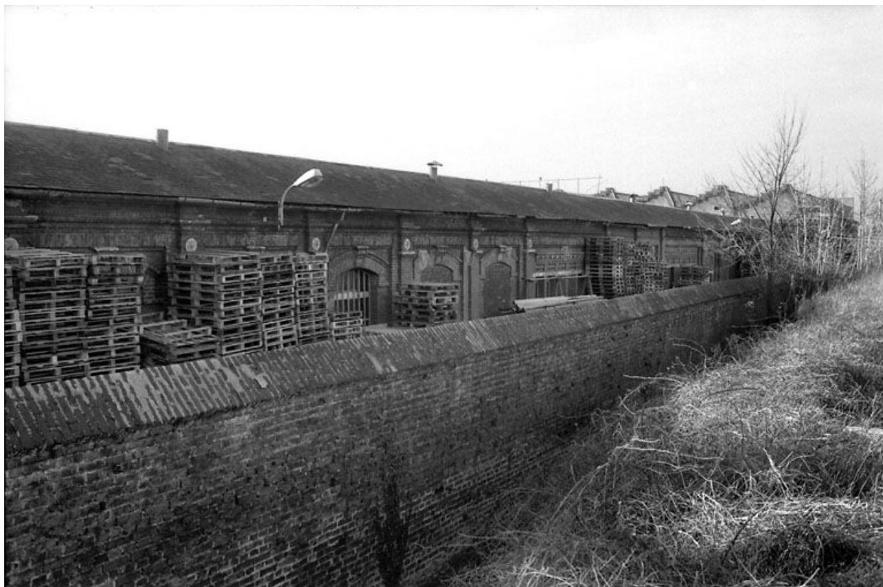
Atelier de fabrication (1), flanc est.
