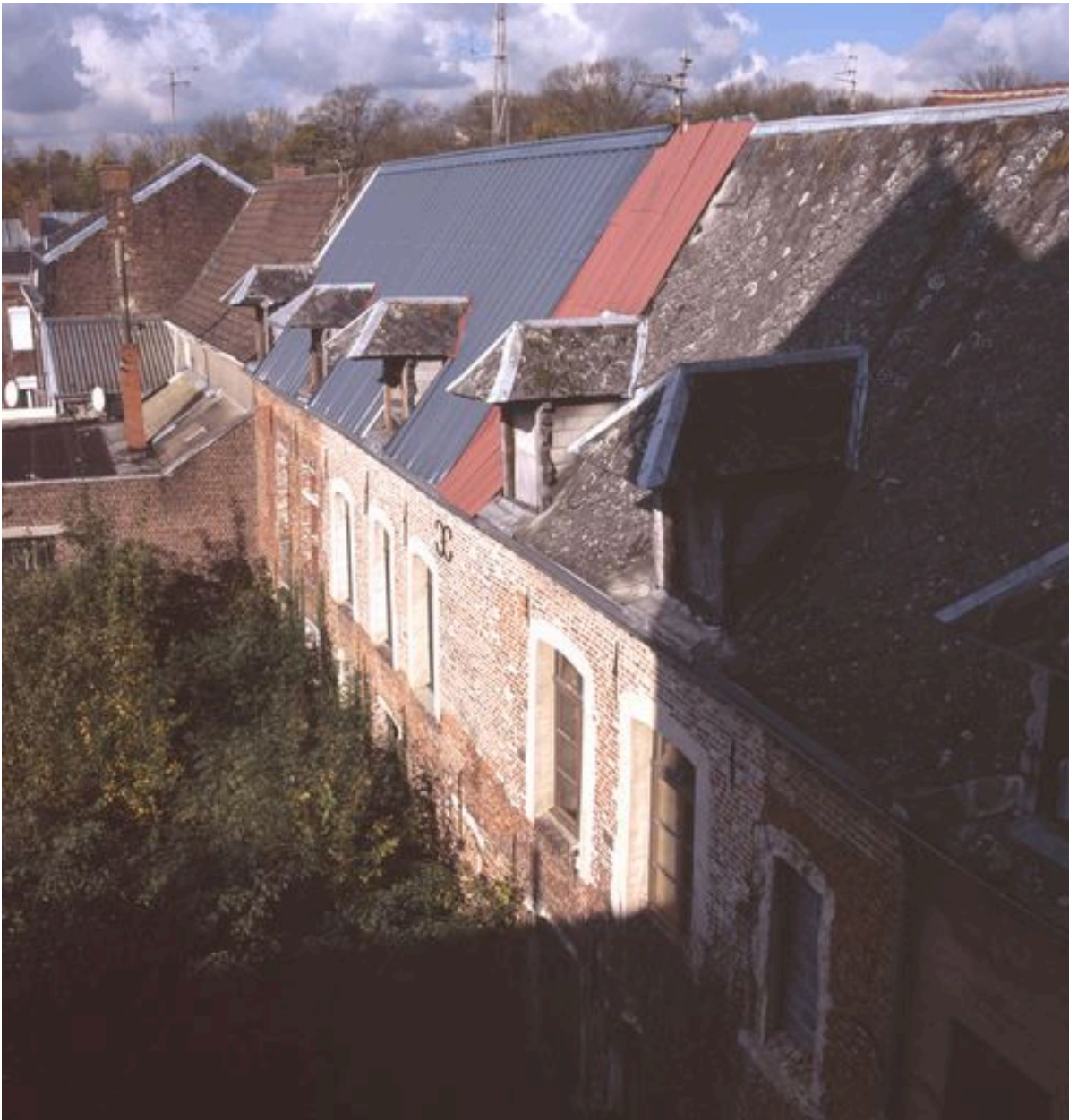
Aile de la rue de la Bibliothèque : vue depuis la grande salle (2e étage) du corps de logis médiéval.
