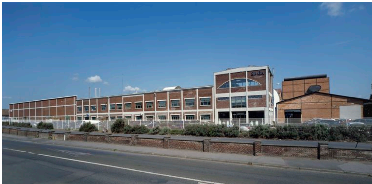
Front bâti de l'entreprise Saga-Décor installée dans les anciens bâtiments de la Cerabati
