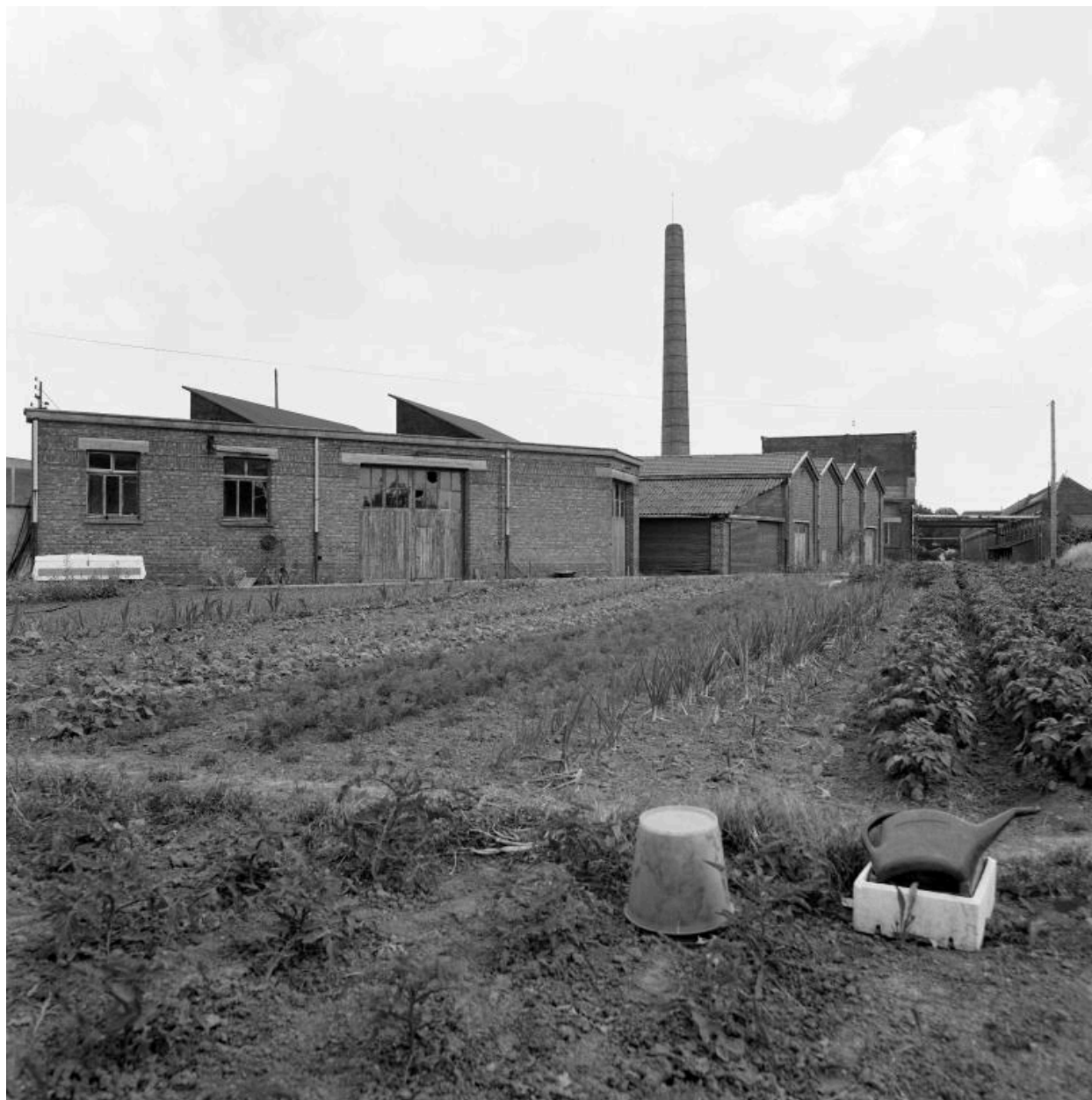
Vue générale vers le sud, prise depuis les jardins ouvriers. De gauche à droite : hangar aux bois, menuiserie, chaufferie, cheminée et salle des machines.
