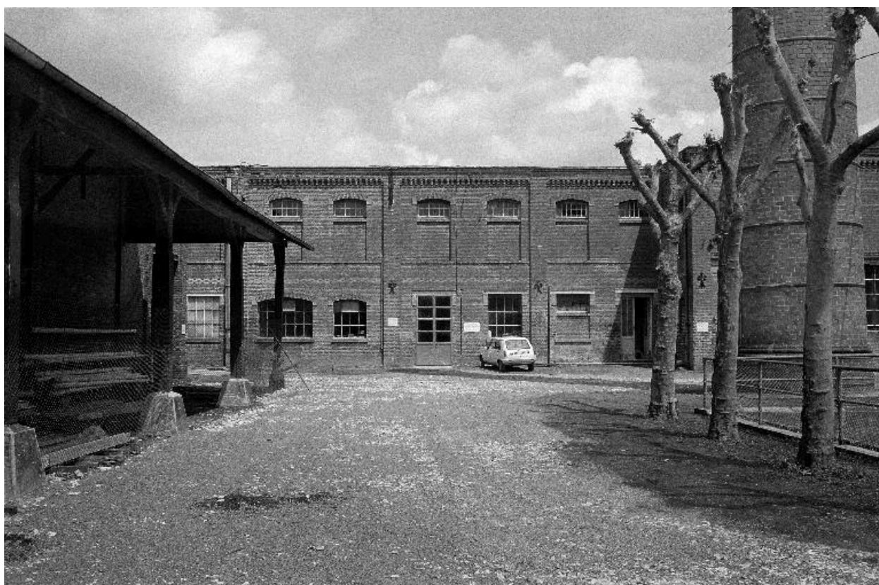
Atelier de fabrication, vue partielle, flanc sud.
