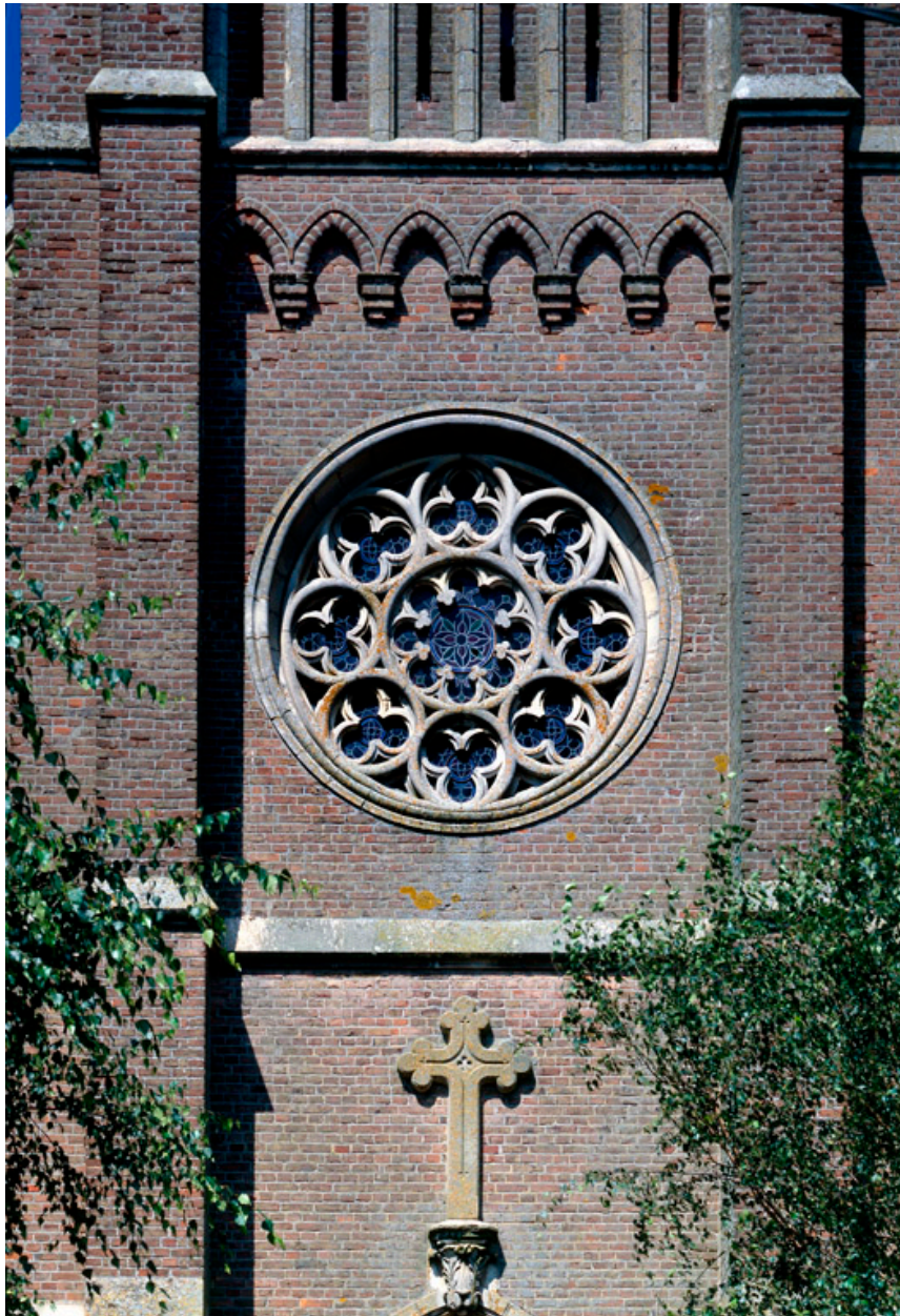
Détail de la rose en façade.
