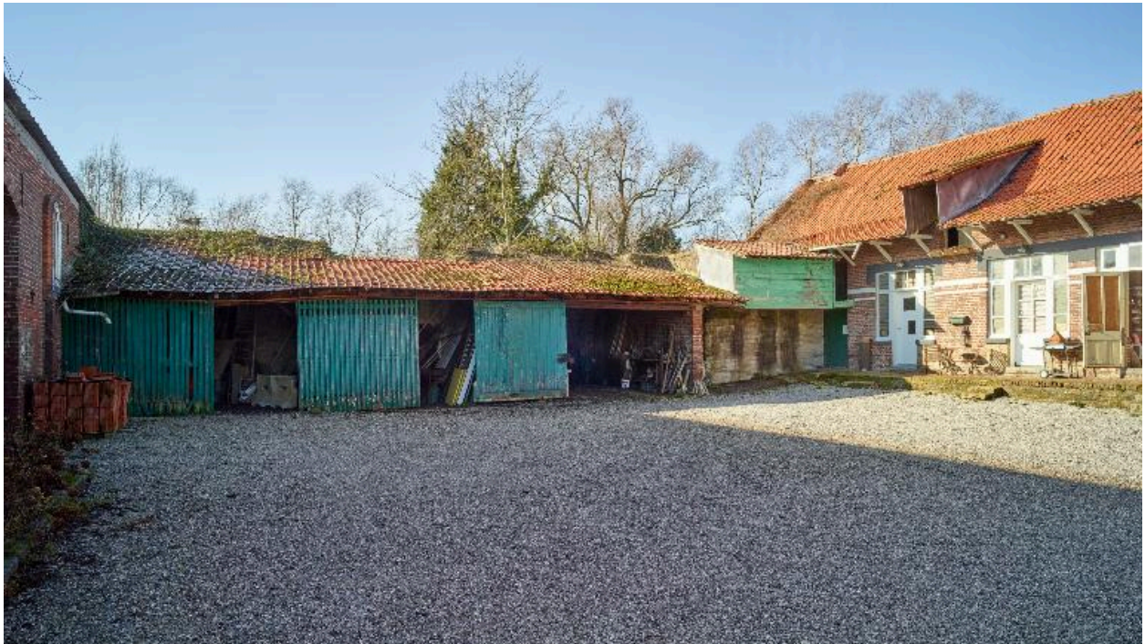
Aile ouest de la ferme depuis la cour.
