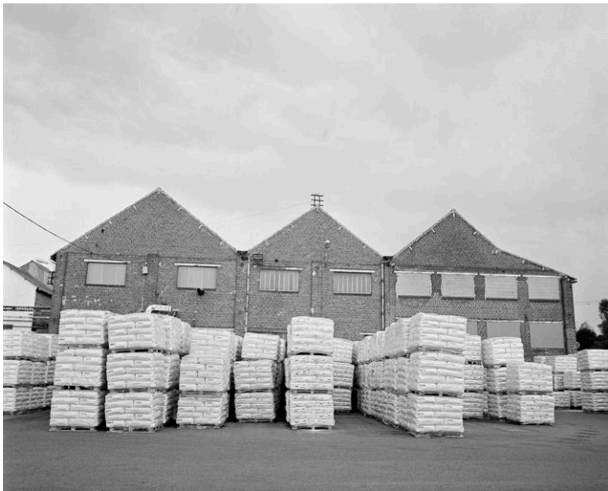
Atelier de fabrication et salle des machines.
